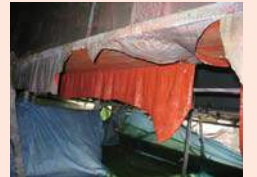
塗膜の除去状況
