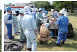
排水ポンプ搭載作業
