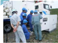
操作盤接続作業
