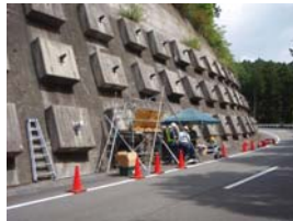
施工後に設置
