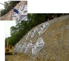
施工時に設置
