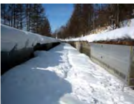
冬期間の試験施工区間の状況
