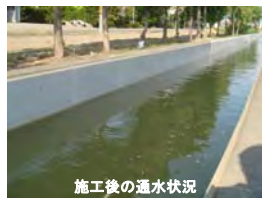
施工後の通水状況
