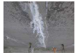
析出物があると、注入出来ないとの理由でUカット充填工法を採用する事例も多い
