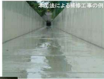
本工法による補修工事の例
