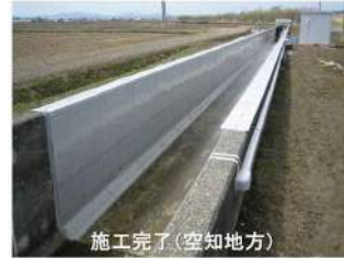
施工完了(空知地方)
