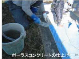
ポーラスコンクリートの仕上げ
