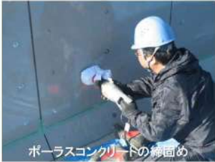
ポーラスコンクリートの締固め
