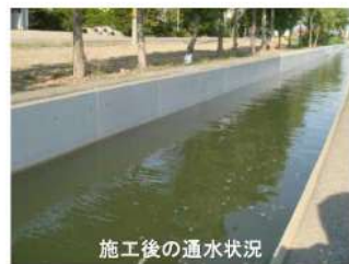
施工後の通水状況
