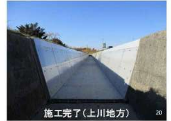
施工完了(上川地方)
