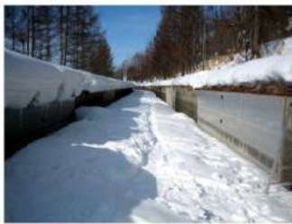
冬期間の試験施工区間の状況
