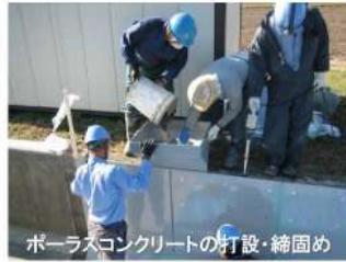
ポーラスコンクリートの打設・締固め
