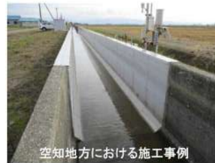
空知地方における施工事例
