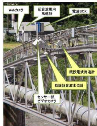
右岸(局舎近く)から撮影
