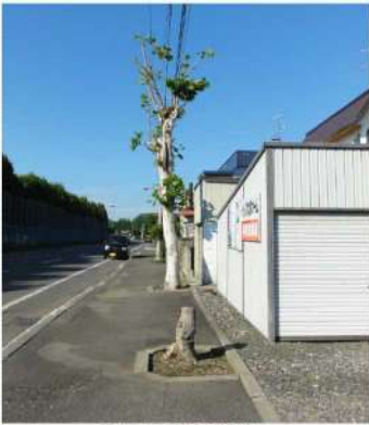
腐朽によって切られた街路樹
