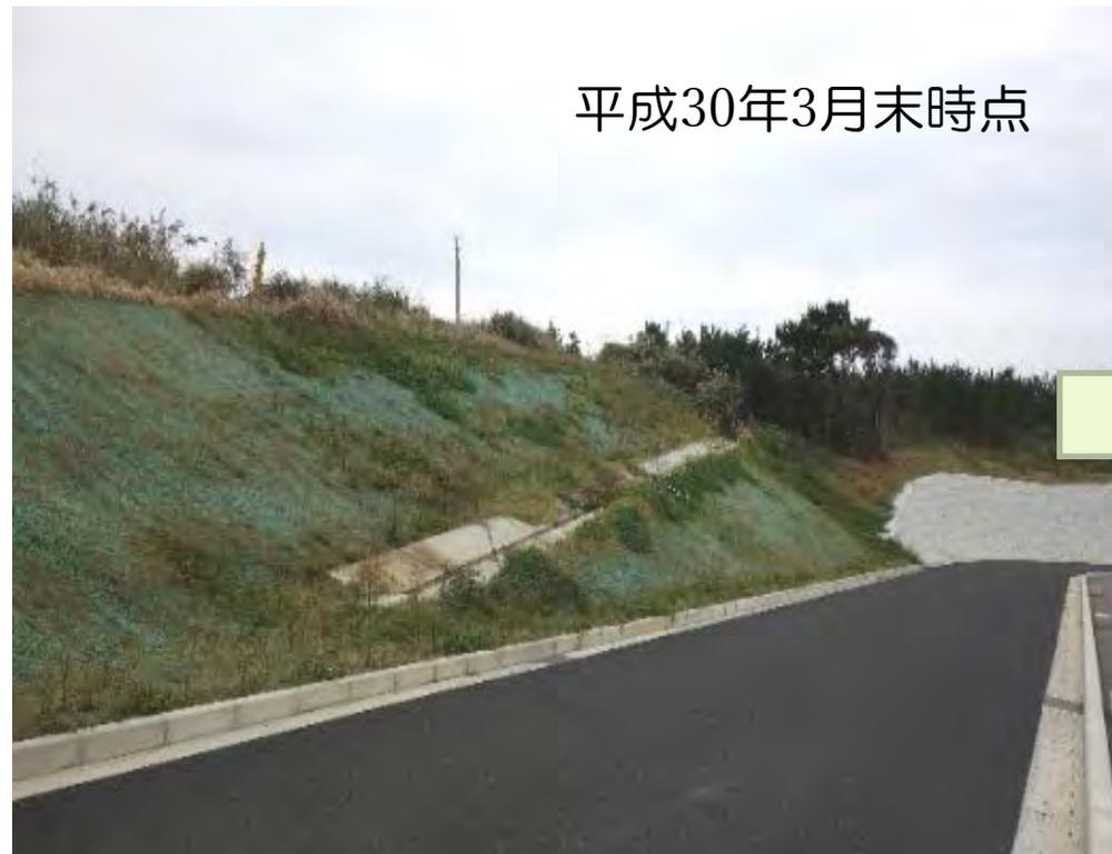
侵食で基盤が露出・肥料分が流出し、生育不良状態の植生シート工の現場。
