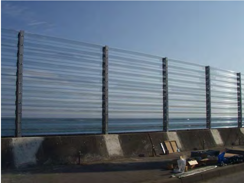
平成19年度一般国道36号白老町
