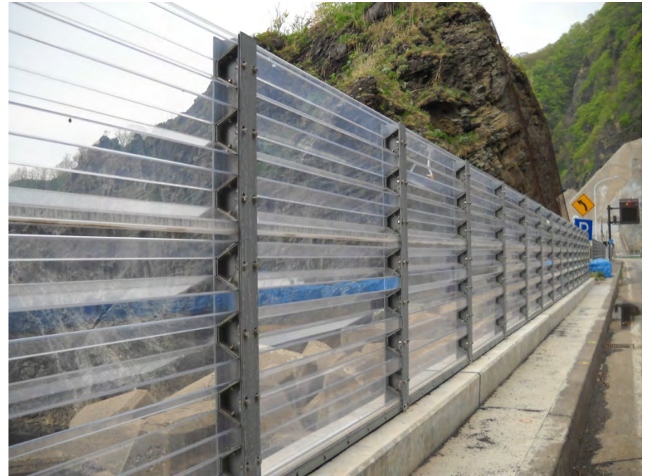
4年経過後の状況
