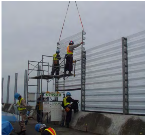
H鋼と部材をボルトで接合
