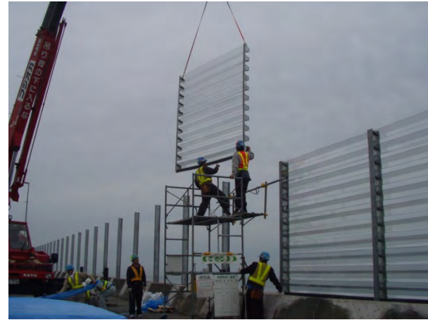
H鋼支柱間に上部より挿入
