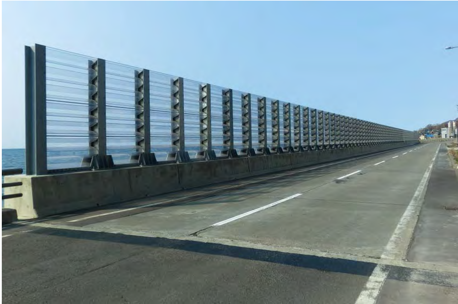
平成23年度 一般国道231号 北海道石狩市
