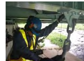
落橋防止装置溶接部点検状況
