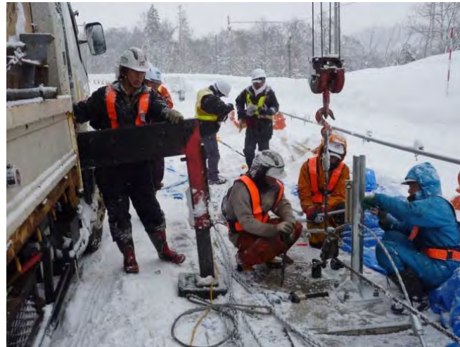
クレーンでワイヤロープを緊張
