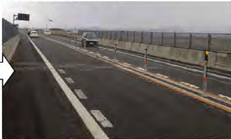
<中小橋部 設置後>
