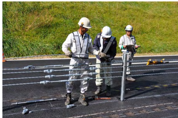
ケーブルカッターで切断
