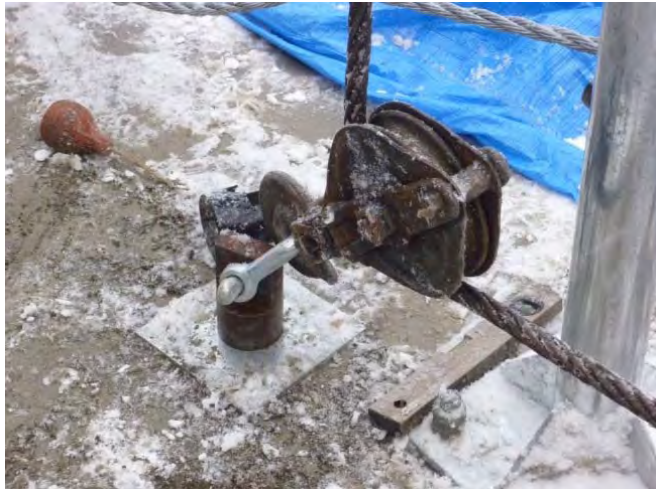
端末基礎にアンカー取り付け
