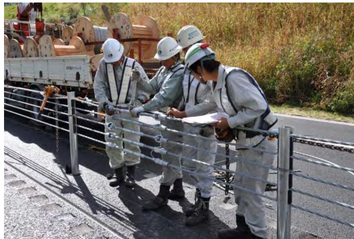
中間ターンバックルの取り付け
