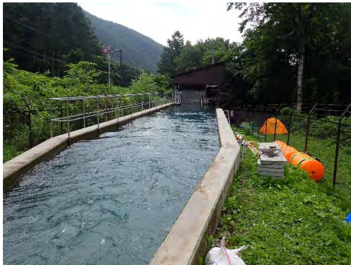
水槽兼沈砂池(運用中)
