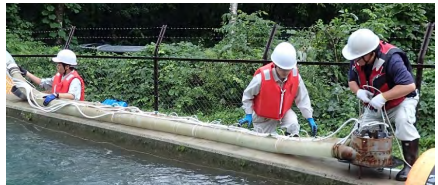
管径100mm潜行吸引式排砂管
