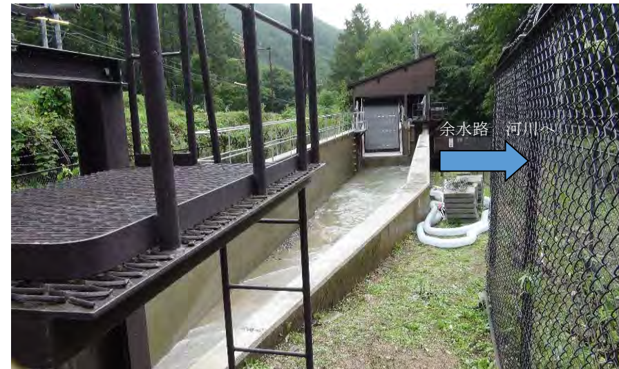
水槽兼沈砂池(排砂時)
