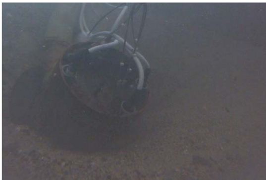
吸引部の土砂吸引の状況(水中)
