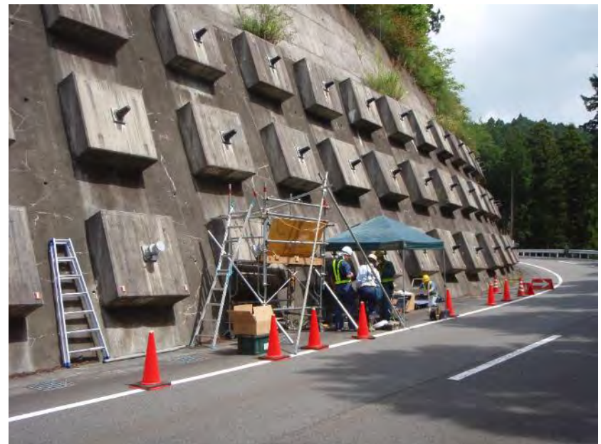
施工後に設置
