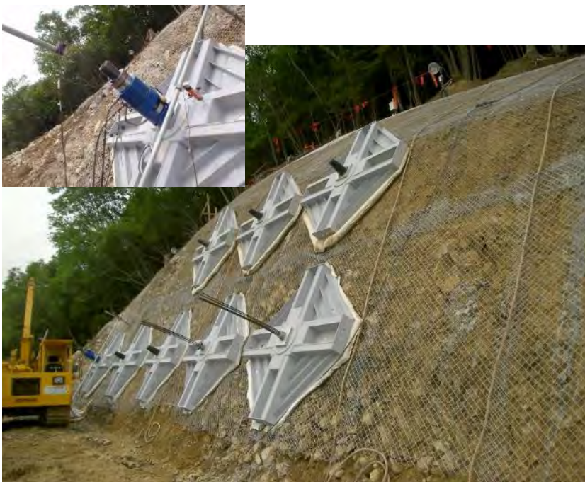
施工時に設置
