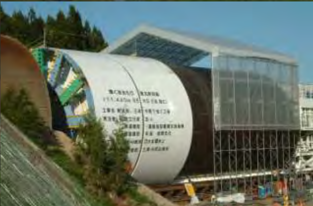
東北新幹線、三本木原トンネル
