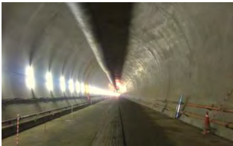
二次覆工完了状況
