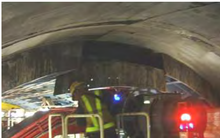
内型枠脱型状況
