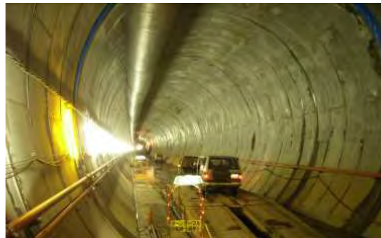
場所打ちライニングの状況
