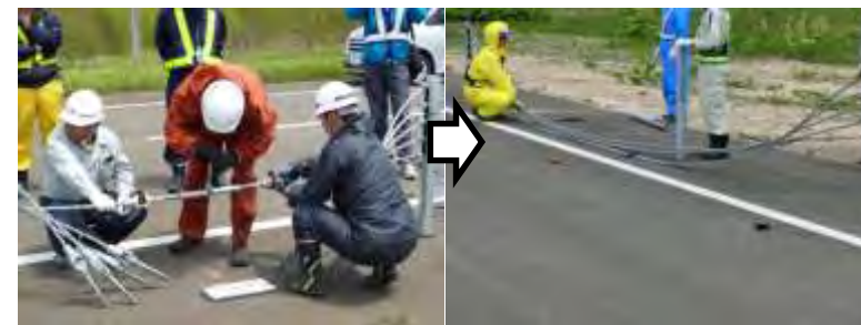
支柱は人力で脱着し、開口部を設置
