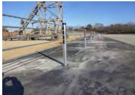
防護柵設置状況 (中間支柱)
