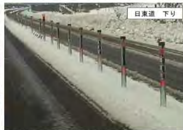
<雪堤の状況写真>
