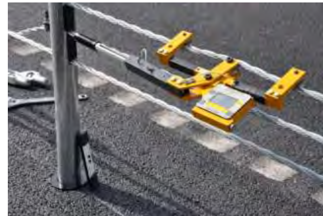
張力計で所定の張力を確認
