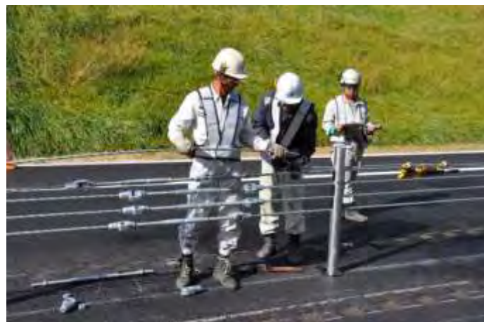
ケーブルカッターで切断
