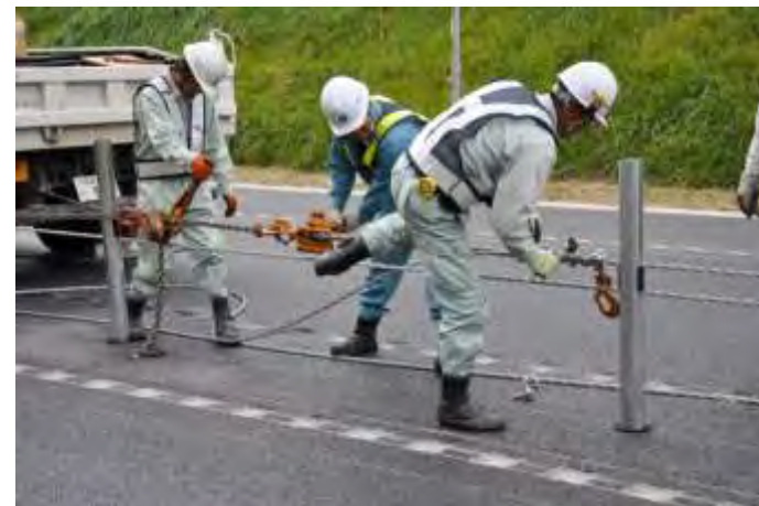
レバーブロックで仮緊張
