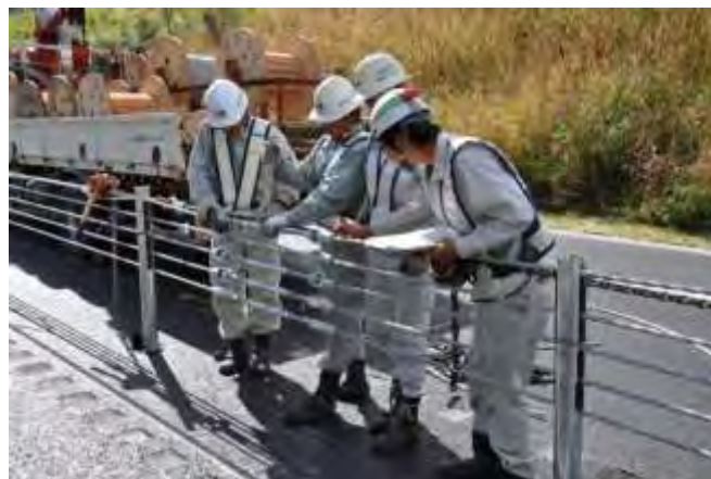
中間ターンバックルの取り付け
