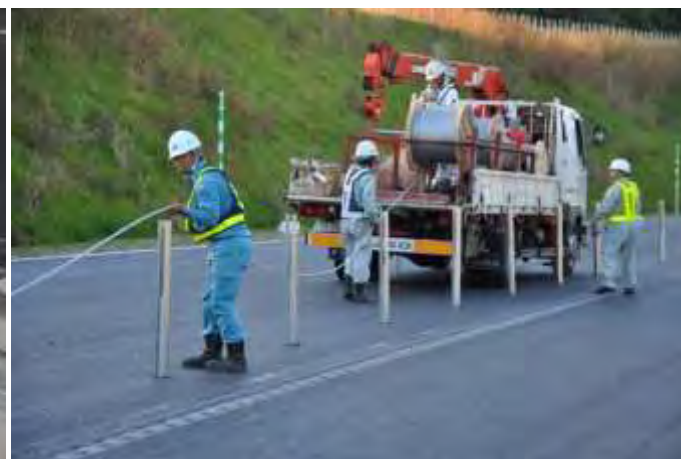
ワイヤロープの設置
