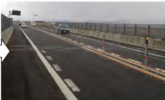
<中小橋部 設置後>
