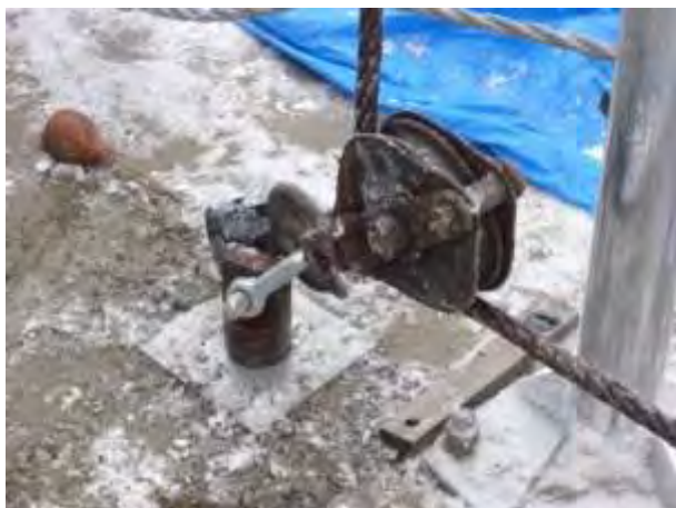
端末基礎にアンカー取り付け
