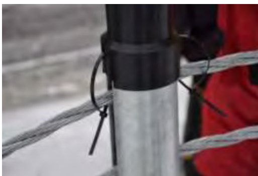
バンドによりワイヤーに固定
