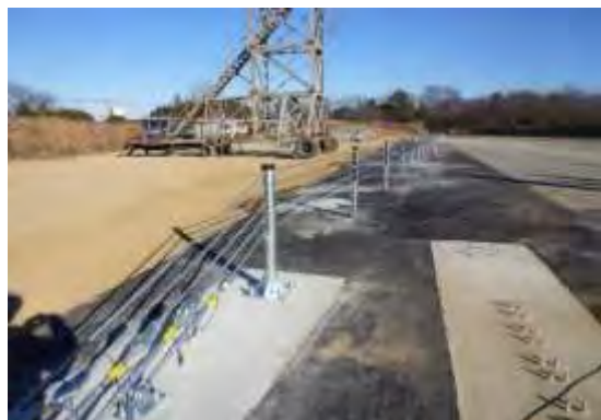
防護柵設置状況 (端末)
