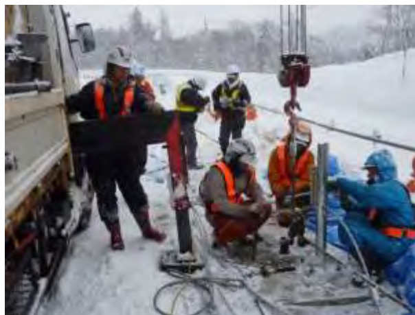
クレーンでワイヤロープを緊張
