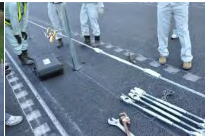
中間ターンバックルの取り付け
