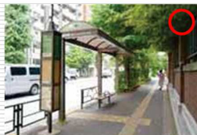
透透性のある屋根材を使用し、歩道空間への圧迫感を軽減している。(出典:資料1)
