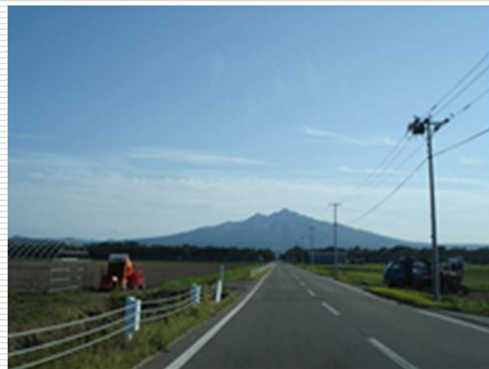
電柱・電線が片側にある山アテの道路
