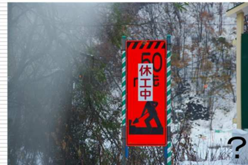
休工中で通行に支障がないにも関わらず、工事の標識が設置されていると、混乱を招く。
