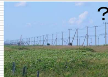
乱立する道路の柱類
