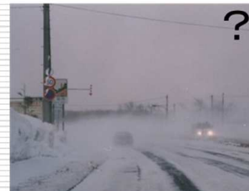
防護柵によって雪堤がある区間での視程障害
