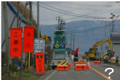
同じ場所に、蛍光色で誘目性が高い仮設の標識等が多数設置されており、より重要な誘導員が目立たない。
