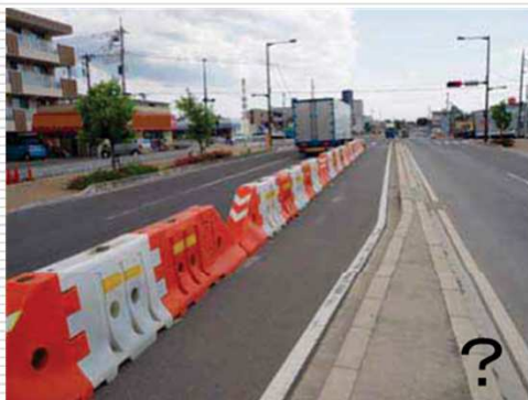
仮設の防護柵が目立ちすぎている仮設の防護柵が目立ちすぎている。(出典:資料1)
