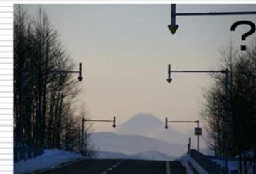
良好な景観を阻害する道路附属施設
