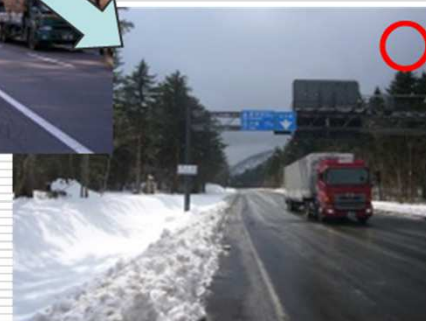
近接して設置されている標識を、一本の支柱にまとめて設置したり、他の道路附属施設に共架することで、煩雑な景観を改善します。
