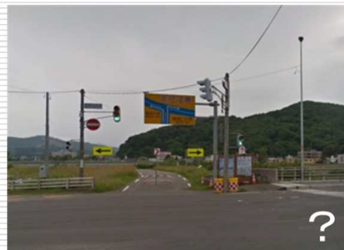
暫定供用の際に多いT字路は、特に、過剰に標識類が設置されやすい。(出典:Google ストリートビュー)
