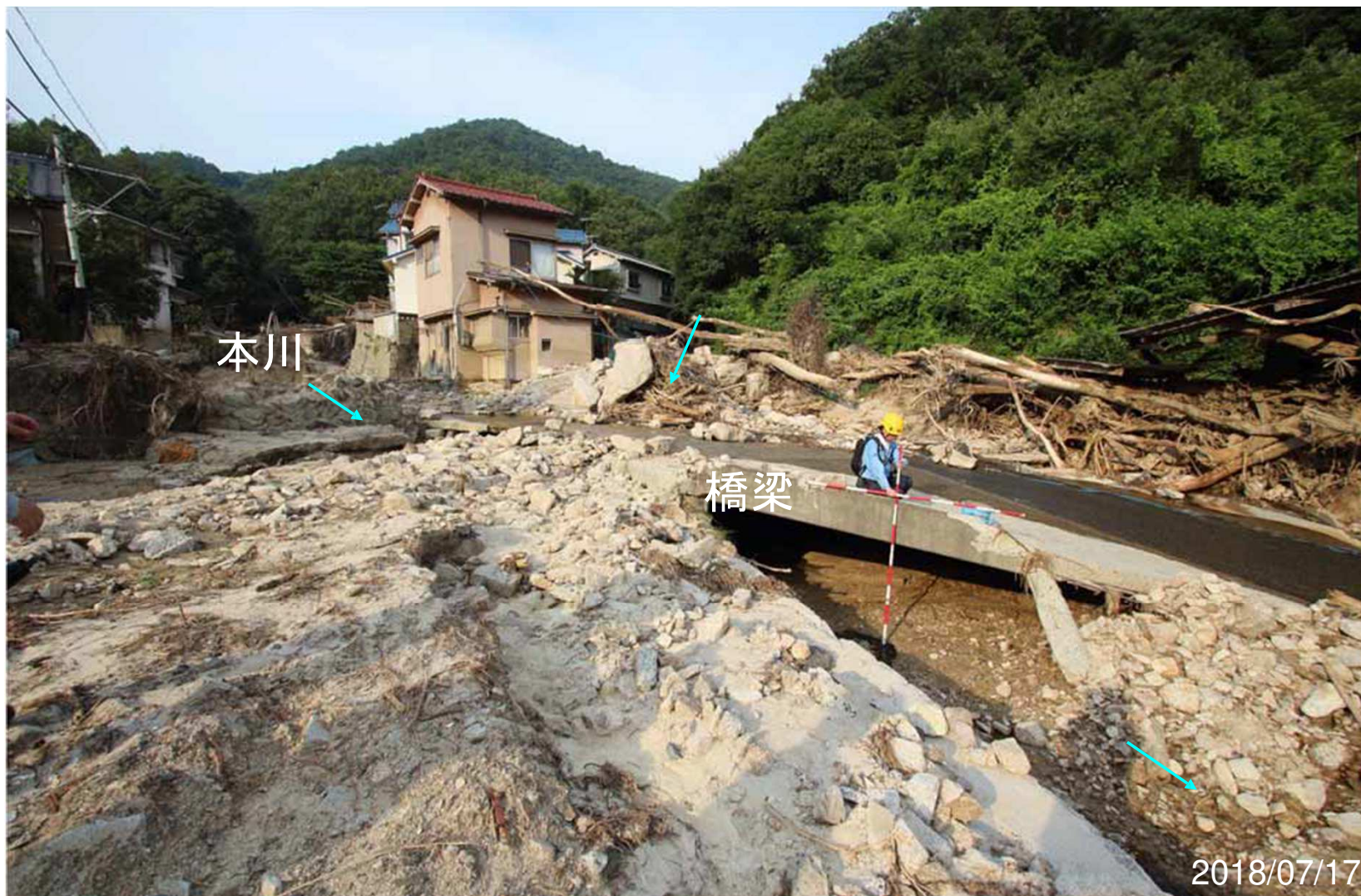
本川からの土石流による土砂と流木は地区上流の橋梁部を閉塞させた。橋梁直上流の河道は土砂により埋没。
