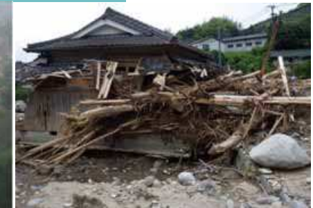
図 流木による被害
