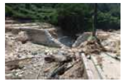
H30年8月豪雨災害で破壊した砂防堰堤
