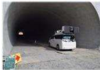
写真7. MMSによる計測状況
