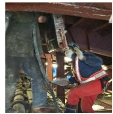
写真5. 見える化情報に基づいて締固め不足箇所を指示・改善。締固め不足を防止。
