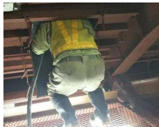
写真1. 検査窓からのバイブレータによる締固め作業
