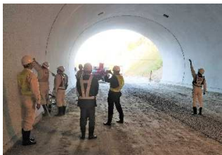
写真3. トンネル断面完成状況
