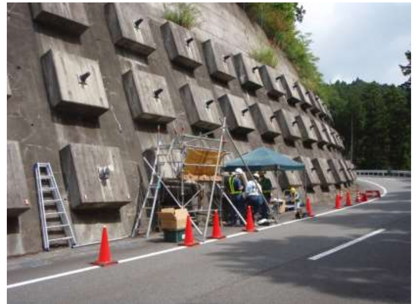
施工後に設置
