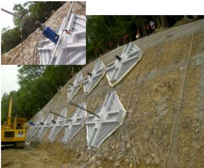
施工時に設置
