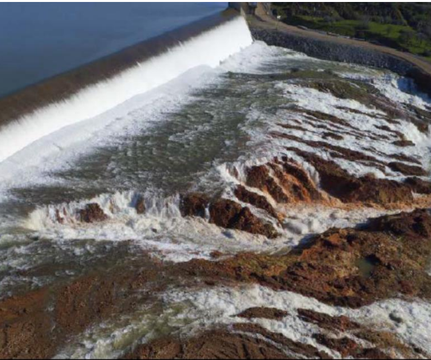
Oroville dam (米・1968年完成) 洪水吐き損傷事故 (2017・避難命令18万人)
