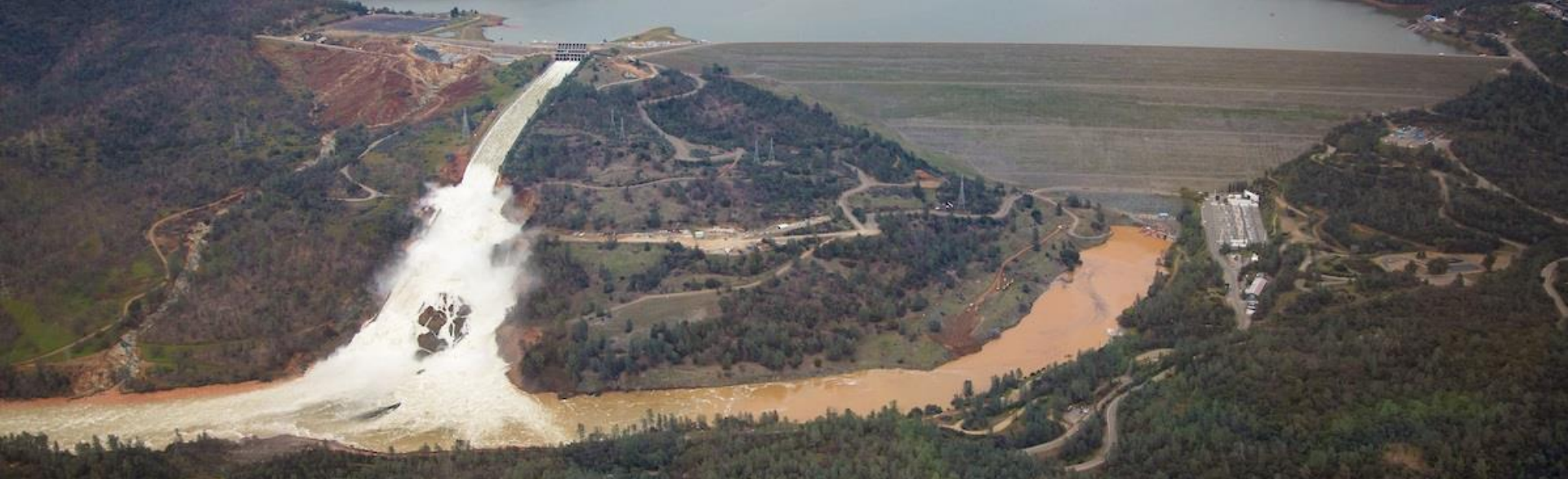
Oroville dam (米・1968年完成) 洪水吐き損傷事故 (2017・避難命令18万人)
