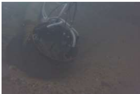
吸引部の土砂吸引の状況(水中)
