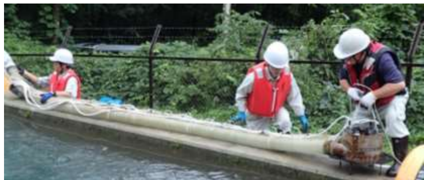
管径100mm潜行吸引式排砂管
