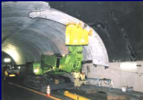
①施工写真
