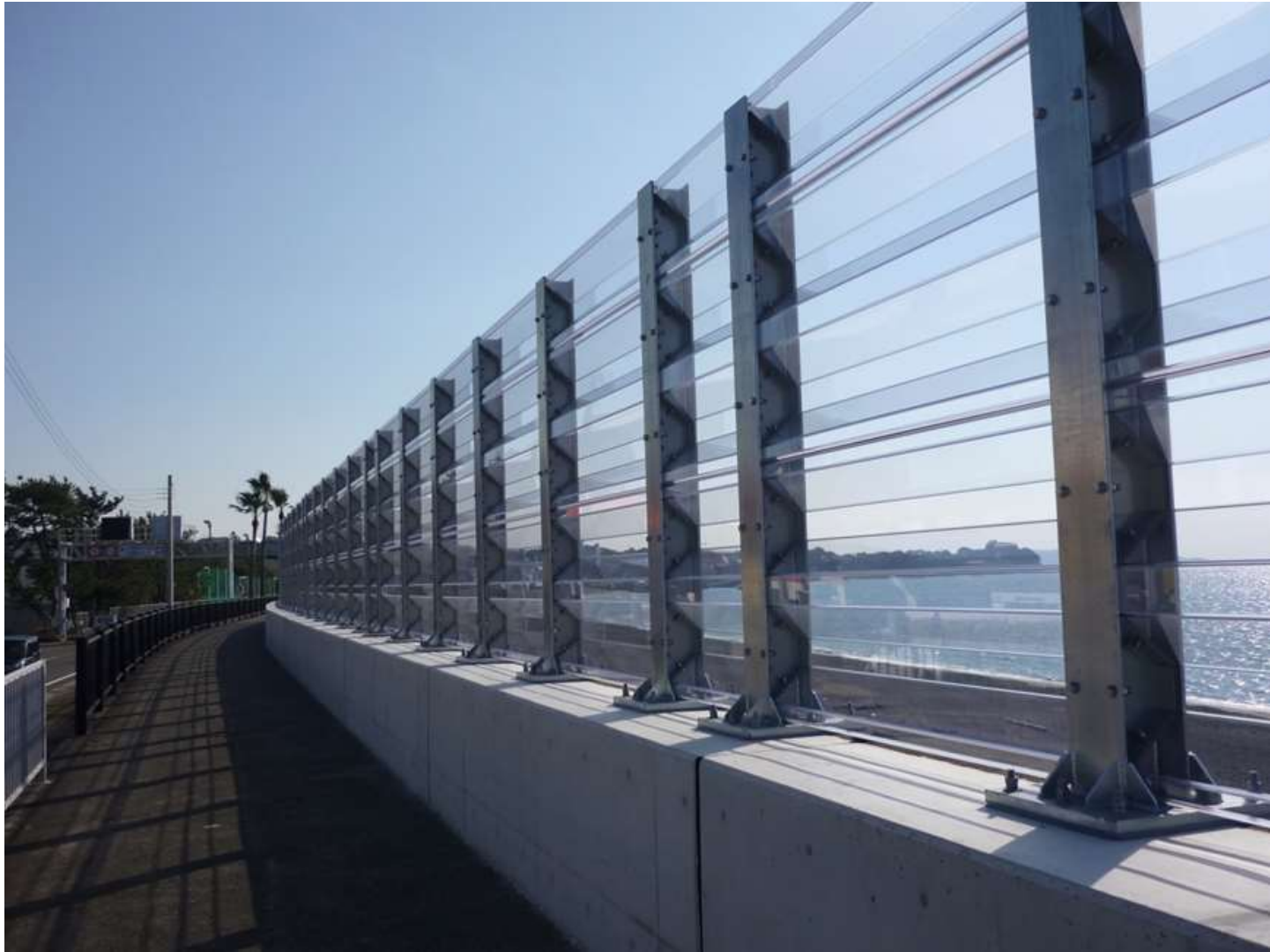
平成26年度 一般国道42号 和歌山県みなべ町
