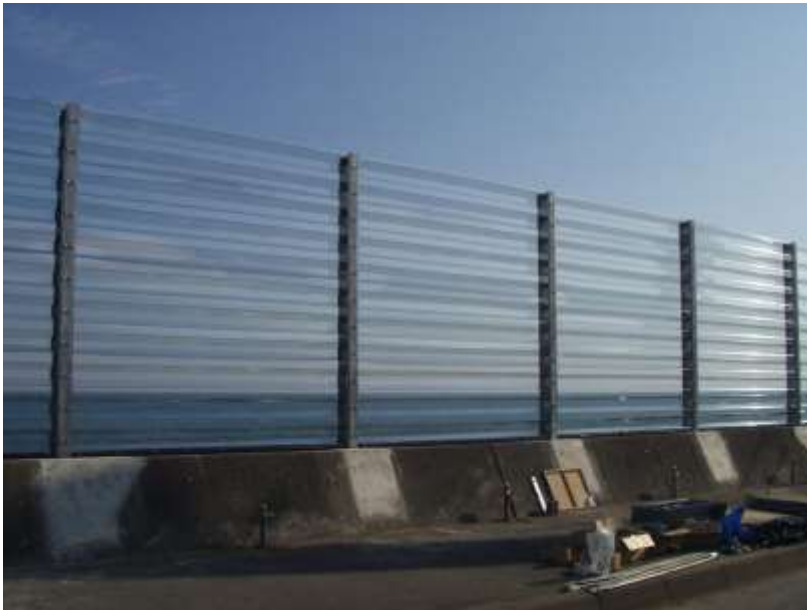
平成19年度一般国道36号白老町
