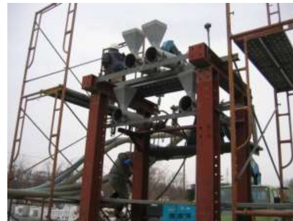
放水実験装置
