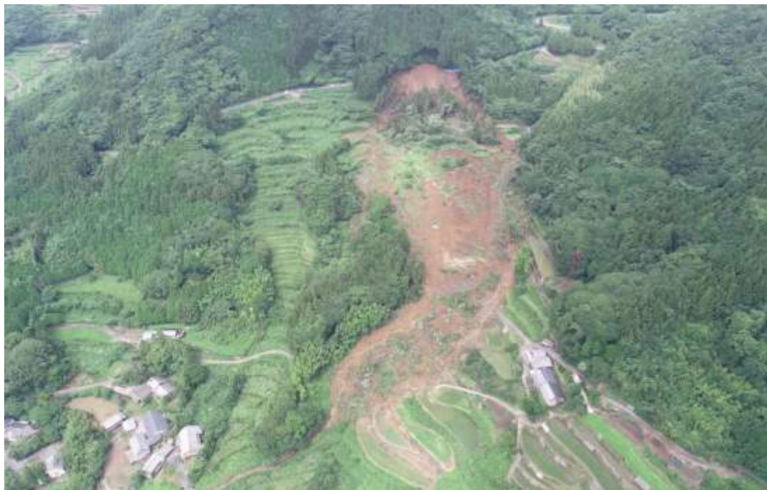
地すべり全景
