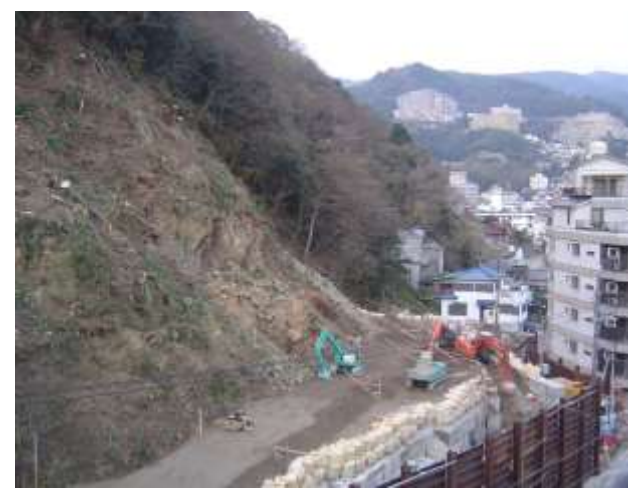
応急対策工事 (押え盛土工)
