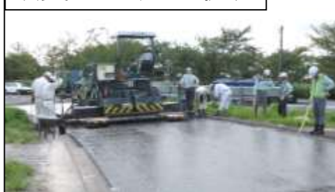
改質グース施工状況
