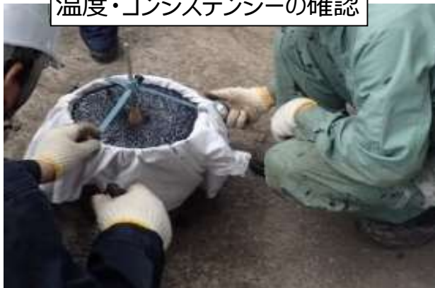
温度・コンシステンシーの確認
