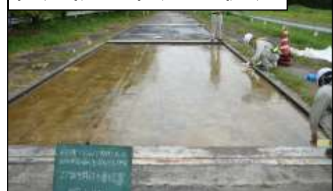
樹脂防水材料施工状況
