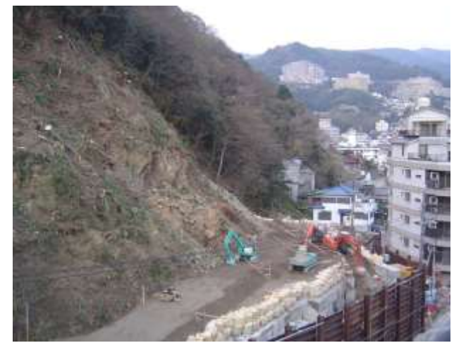
応急対策工事 (押え盛土工)
