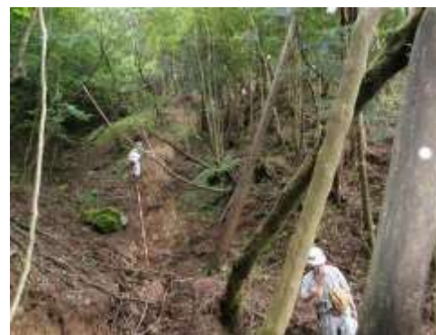
③地すべり頭部から側部に繋がる亀裂
