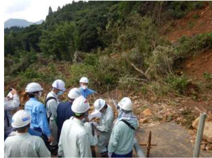
現地調査の状況
