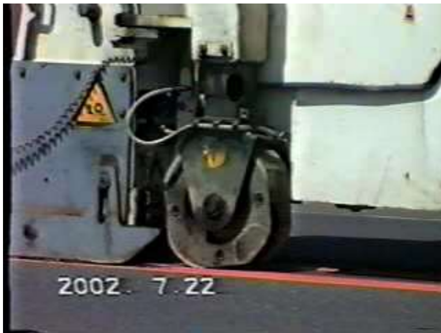
専用施工機械による施工状況
