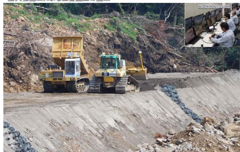
無人化施工による土留盛土の施工
