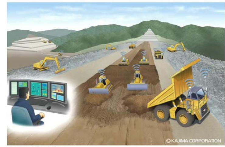
A/CSELのダム媒体での施工イメージ
