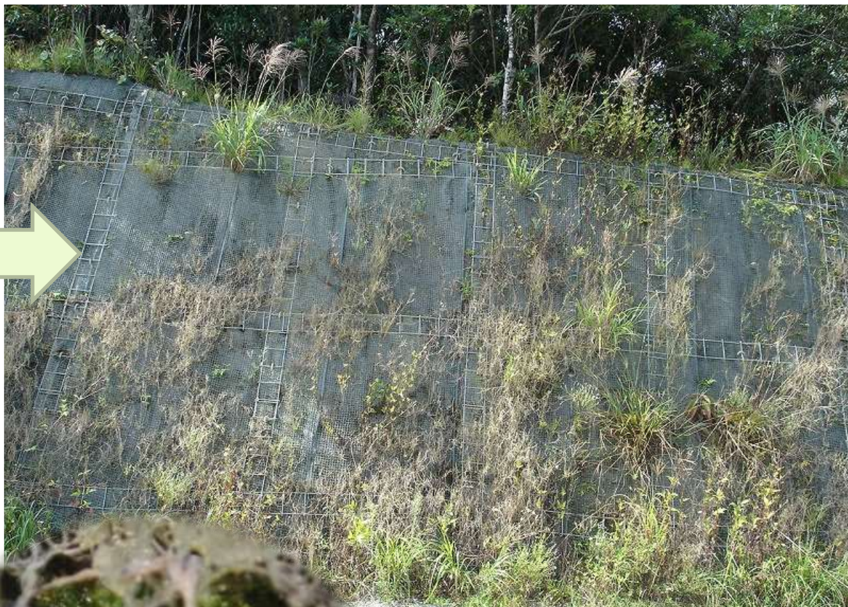
施工後（5カ月経過）
