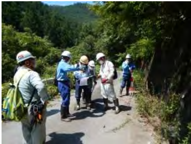
道路周辺の変状の確認
