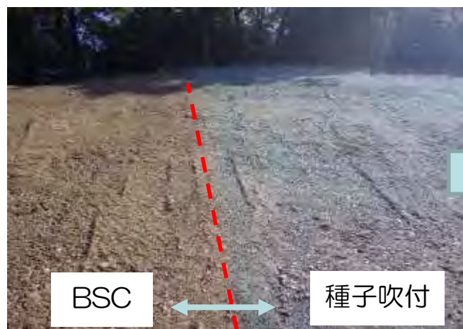
平成29年11月（施工時）
