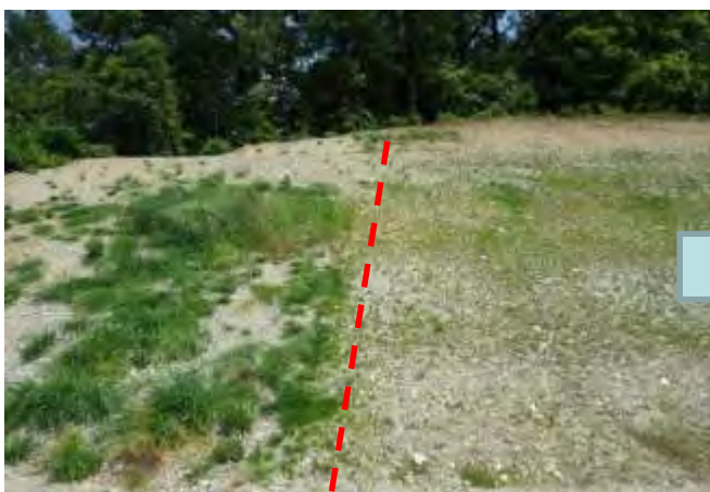
平成30年5月（施工後6.5ヶ月）
