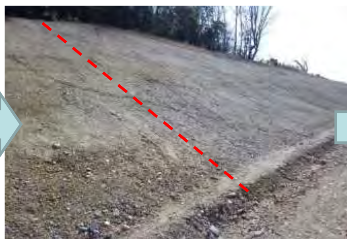
平成30年2月（施工後3.5ヶ月）
