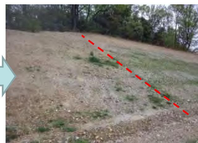
平成30年4月（施工後5ヶ月）
