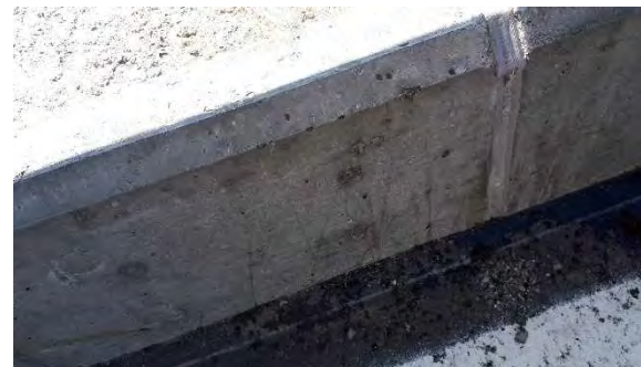
北海道内の 道路橋地覆への適用
