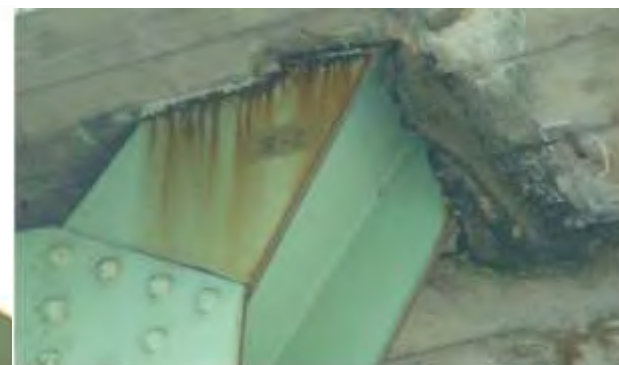
コンクリート埋設部
