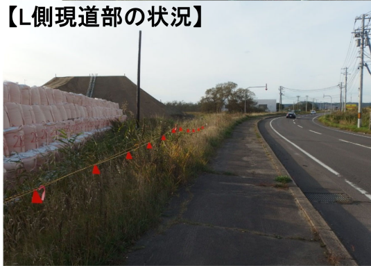
【L側現道部の状況】
