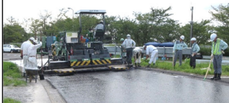
樹脂防水材料施工状況
