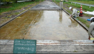
樹脂防水材料施工状況
