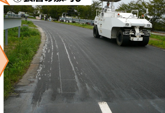
④表層の敷均し
