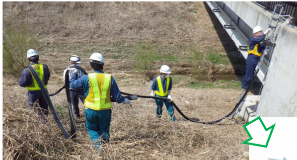
真空引きした後、 先導ワイヤに接続
