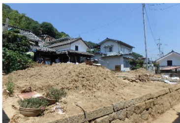
洪水後市街地に土砂が堆積している様子
