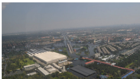
工業団地の浸水状況
