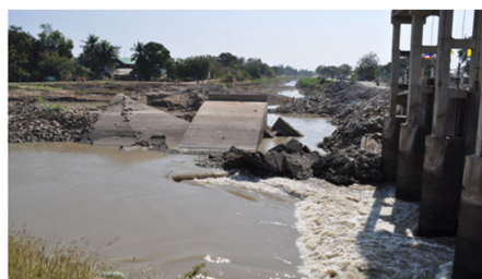
チャオプラヤ川洪水災害(破堤)の状況
