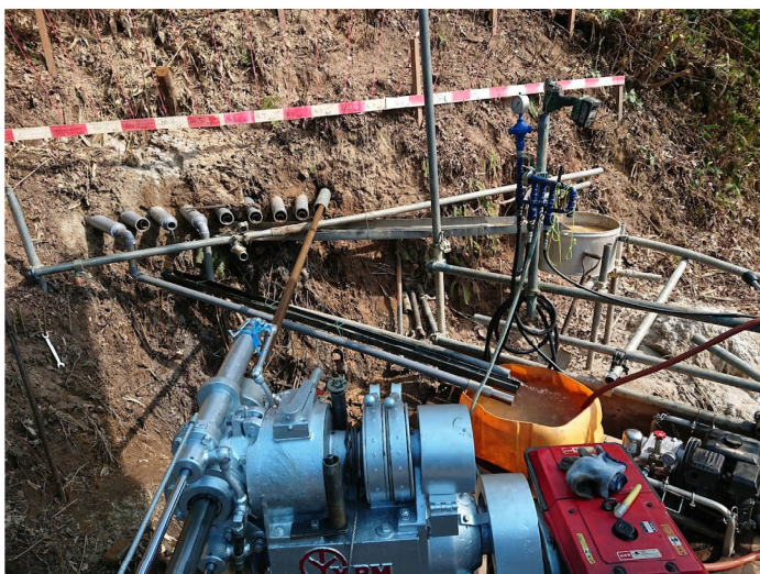
応急横ボーリング工の施工
