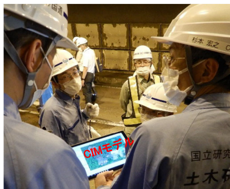
地すべりとトンネル位置の確認
