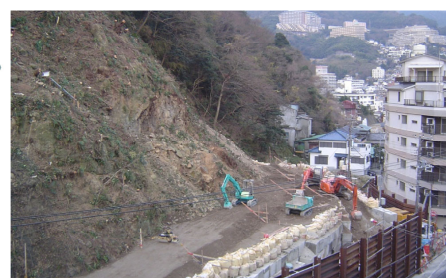
応急対策工事
