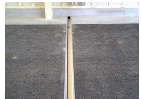
写真4 舗装の溝（トレンチ）
