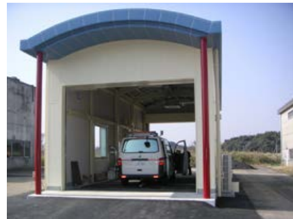
写真-1 施設外観
