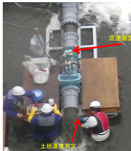
土砂濃度だけは直接採取により計測
