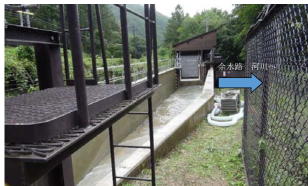
水槽兼沈砂池(排砂時)
