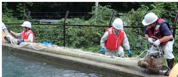
管径100mm潜行吸引式排砂管
