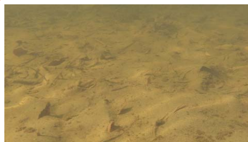
貯砂ダム上流の河床の状況
