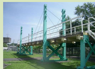
FRPの歩道橋構造物への適用と耐久性検討 (主部材: 構造用GFRP, 斜材: CFRPケーブル)
