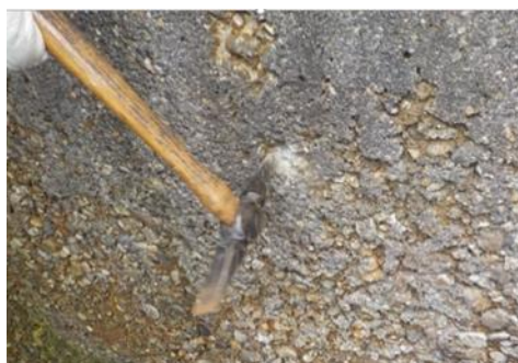
Figure1:硫酸による腐食例
