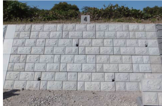
護岸ブロック敷設(正面) 改良後
