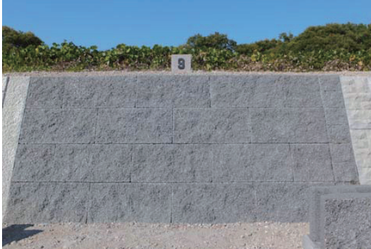
護岸ブロック敷設(正面)
