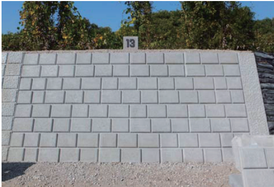
護岸ブロック敷設(正面)
