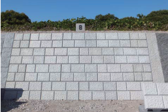
護岸ブロック敷設(正面)
