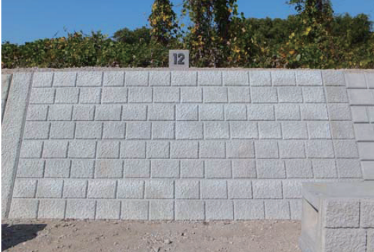
護岸ブロック敷設(正面) 改良後
