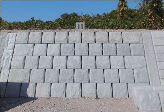
護岸ブロック敷設(正面)
