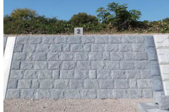
護岸ブロック敷設(正面) 改良後
