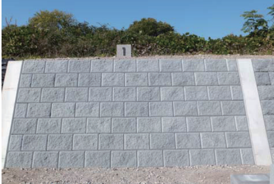
護岸ブロック敷設(正面) 改良前
