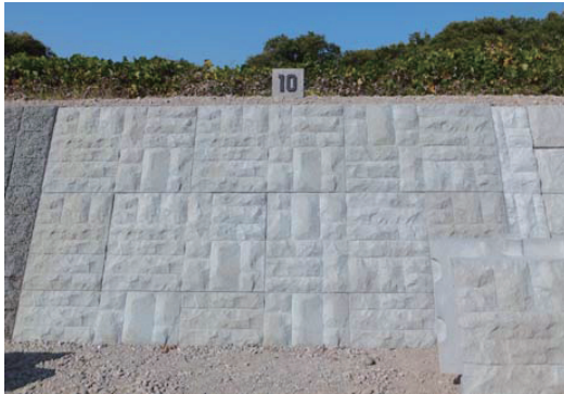
護岸ブロック敷設(正面)
