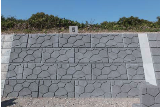
護岸ブロック敷設(正面) 改良前
