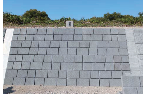
護岸ブロック敷設(正面) 改良後
