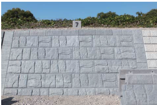
護岸ブロック敷設(正面)
