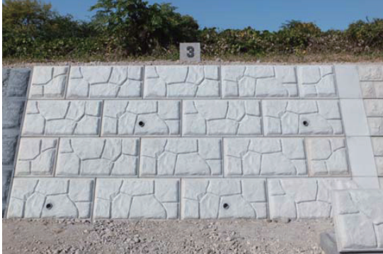
護岸ブロック敷設(正面) 改良前
