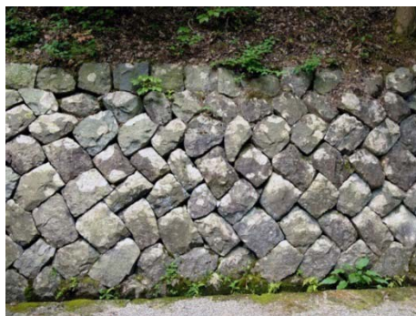
写真-3.12 石積み護岸
