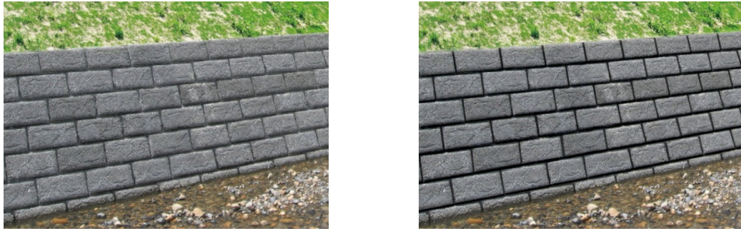
写真-6.8 目地が浅い場合（左）と目地が深い場合（右）
