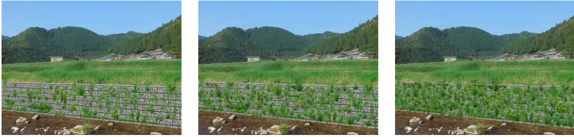
写真-6.24 植被率の違いの例（穴あき，草丈 混合の場合）
