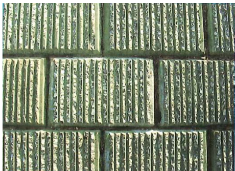
写真-3.16 表面を線状に搔き、 骨材の表情を出したブロック
