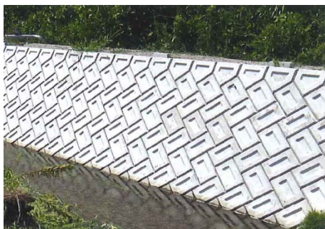
写真-3.4 滑面のコンクリート護岸
