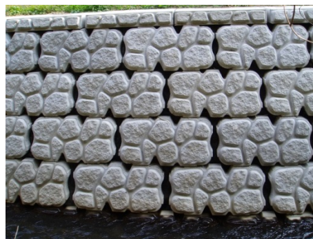
写真-3.13 ブロック護岸
