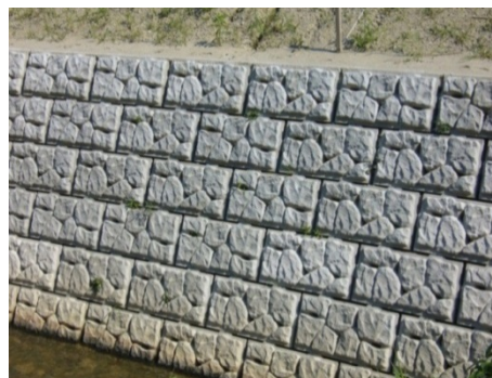
写真-3.9 ブロック護岸
