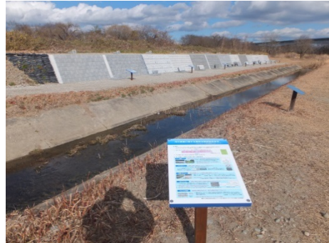
写真-4.1 概略説明用パネルの設置
