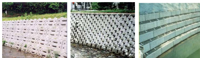
写真-6.23 検討対象とした景観パターン (左：穴あき 中：千鳥-穴あき 右：階段)
