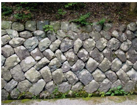
写真-3.8 石積み護岸
