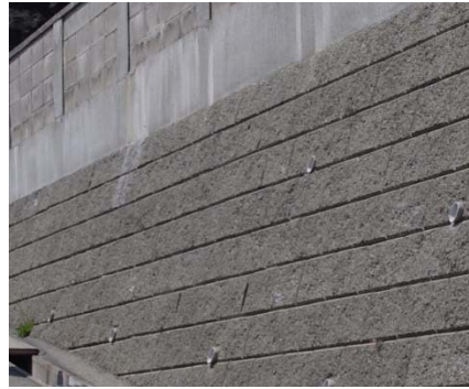
写真-3.19 水抜きパイプが目立つ護岸
