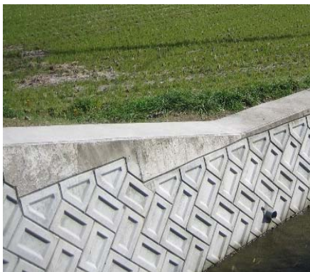
写真-3.2 護岸が周囲に対し目立っている例 (護岸の明度 7.0 程度)
