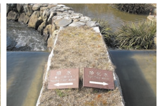
浄化水と原水と比較できる水路
