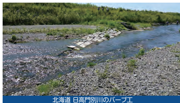
北海道 精進川放水路のバーブ工
