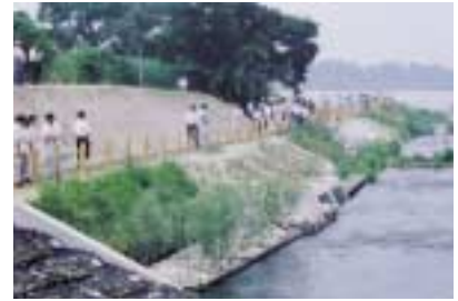
一般に公開されている自然共生工法展示場
