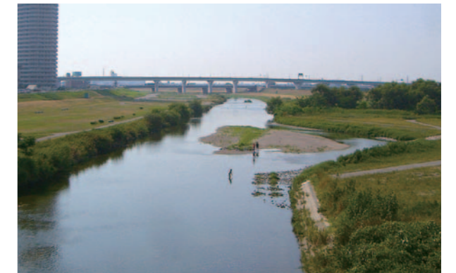
写真1 工法導入後半年が経過した施工地(ワンド造成区)の様子
